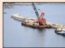
防波堤の拡幅・嵩上げ
