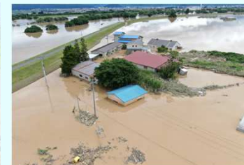
R2.7月豪雨におけるポンプ場冠水状況
