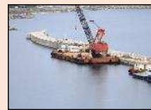
防波堤の拡幅・嵩上げ
