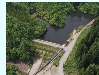
ため池の改修例
