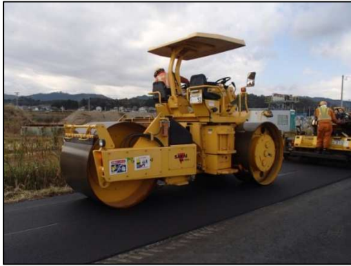
写真 12.7 表面処理工法(アスファルト混合物)施工写真
