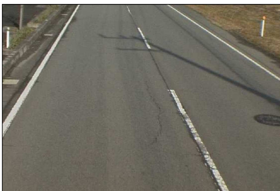
写真 10.1 診断区分 I の事例写真
