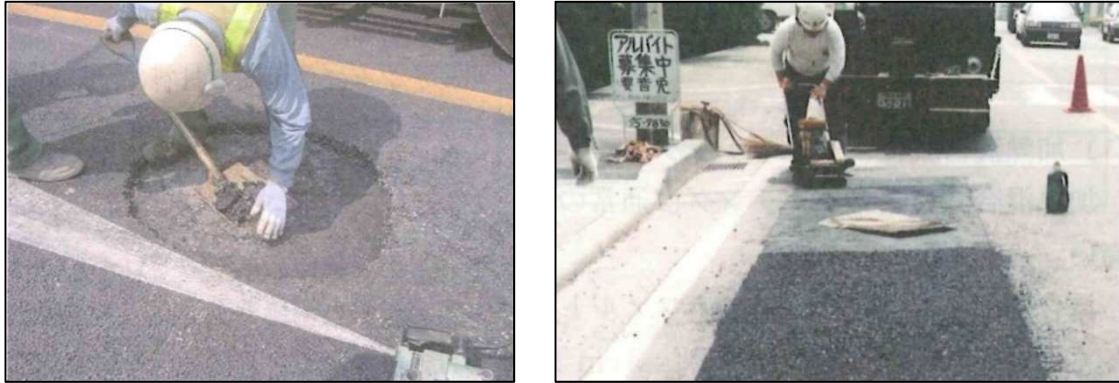
写真 12.1 加熱アスファルト施工写真
