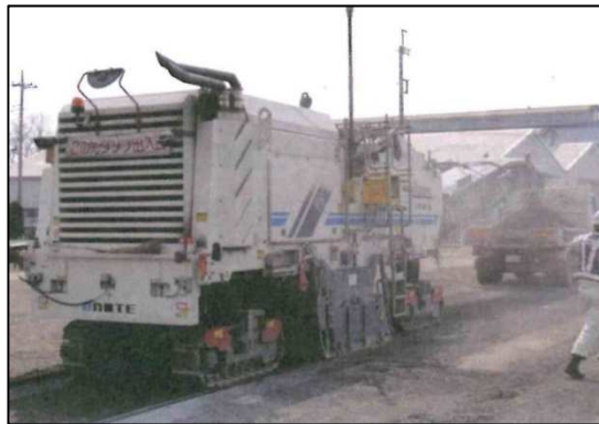
写真 12.8 表面処理工法(切削工法)施工写真
