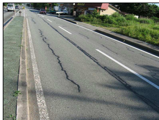
写真 12. 4 クラックシール(加熱アスファルト)施工写真
