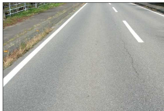
写真 10.1 診断区分 I の事例写真
