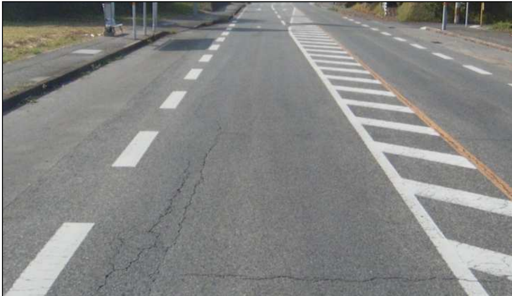
写真 7.1 MCI 5 の路面状況写真
