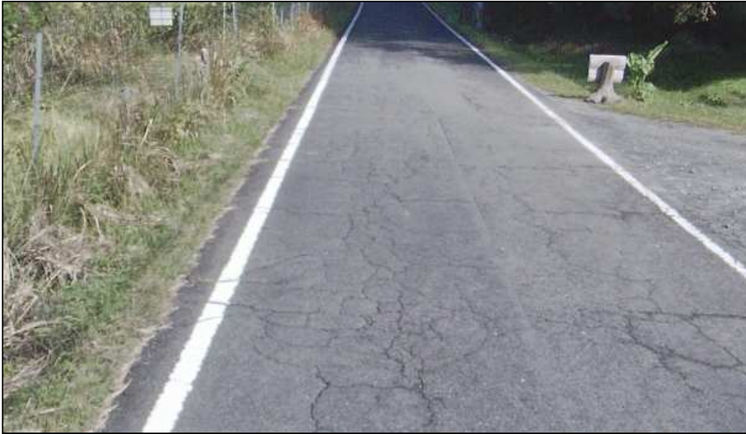
写真 7.4 MCI 2 の路面状況写真
