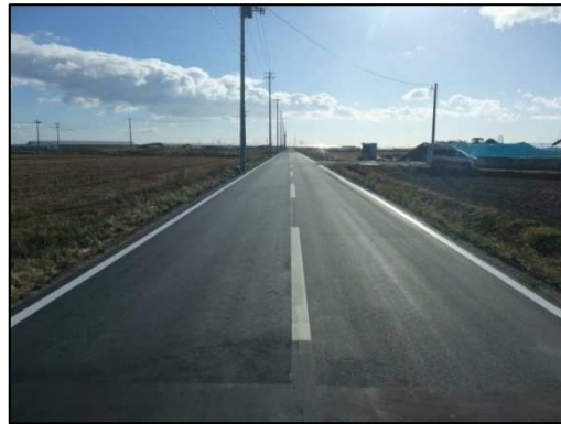
写真 12.7 表面処理工法(アスファルト混合物)施工写真
