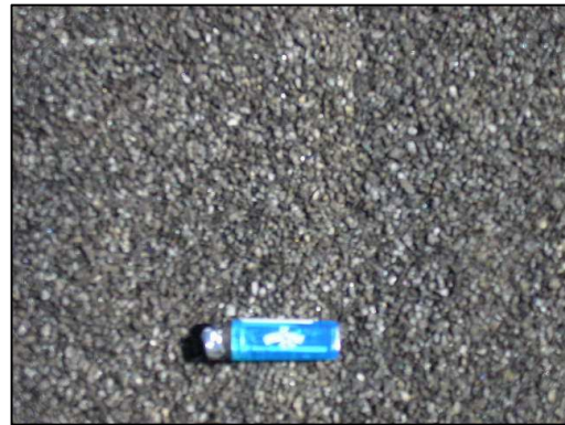
写真 12.6 表面処理工法(アスファルト乳剤系)施工写真
