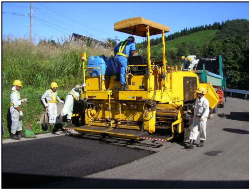
写真 12.6 表面処理工法(アスファルト乳剤系)施工写真
