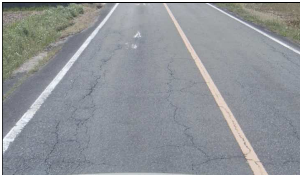
写真 7.3 MCI 3 の路面状況写真
