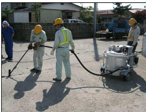
写真 12. 4 クラックシール(加熱アスファルト)施工写真
