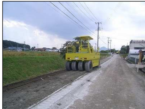
写真 12.10 路上路盤再生工法施工写真
