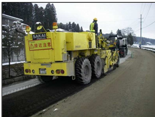
写真 12.10 路上路盤再生工法施工写真
