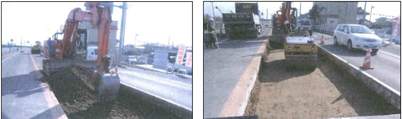
写真 12.9 打換え工法施工写真
