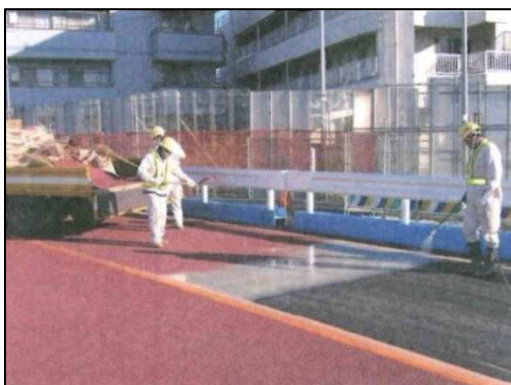
写真 12.7 表面処理工法(樹脂系)施工写真
