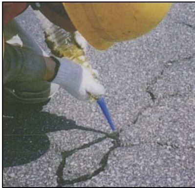
写真 12.5 クラックシール(樹脂系)施工写真
