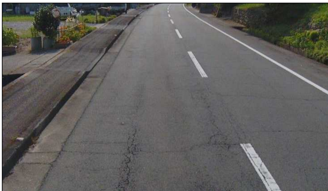
写真 7.2 MCI 4 の路面状況写真
