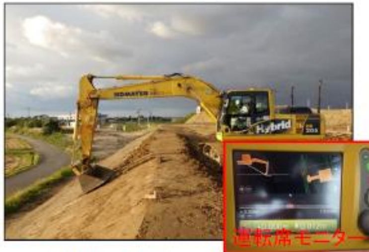
3DMGバックホウによる法面整形
