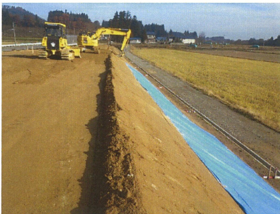
盛土：法面整形
