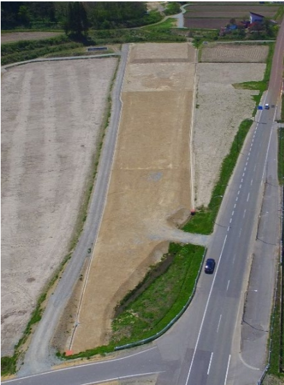
ドローン撮影：着工前時
