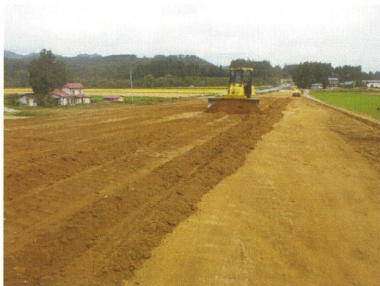
路体盛土：敷均し
