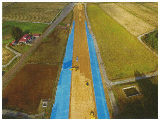
盛土全景 ドローン撮影
