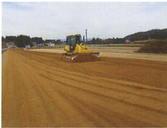
路床盛土：敷均し
