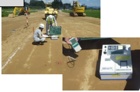
立会：現場密度試験
