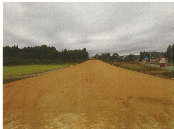
路体盛土：完了
