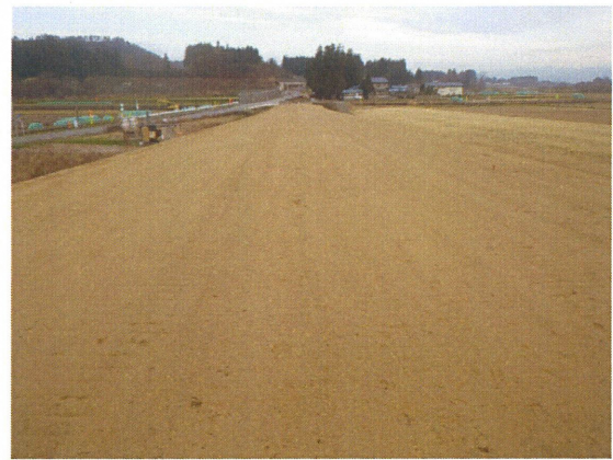
路床盛土：完了
