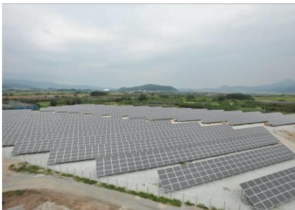
村山浄化センター
