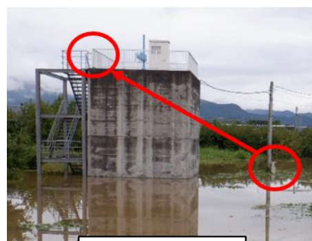
浸水のおそれのある 受電盤の移設
