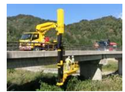
▲ 橋梁点検実施状況
