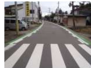
▲路肩カラーリングによる歩行空間確保 (一)万世窪田線 (米沢市川井)
