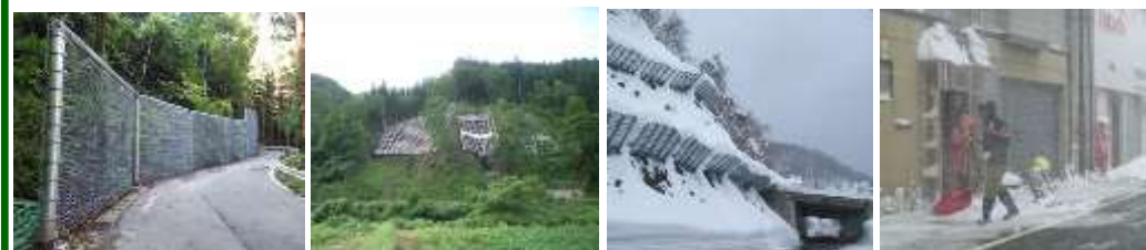
▲防災対策(例) 左:(主)上山七ヶ宿線 (山市) 落石防護柵 右:(主)余目温海線 (鶴岡市) 法面保護工 ▲冬期間の交通安全対策(例) 左:(国)344号 (真室川町) 雪崩予防柵 右:(一)大石田名木沢線 (大石田町) 流雪溝
