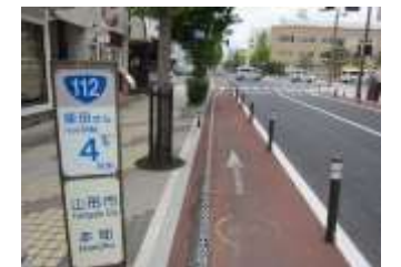
▲路肩幅のカラーリング、ポラードの設置による自転車専用通行帯の分離(国道112号 山形市本町)
