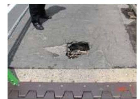
▲ 床板の抜け落ち((主)大石田畑線 亀井田橋)
