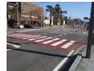
▲交差点カラーリングによる歩行者の視認性向上 (主)鶴岡羽黒線 (鶴岡市馬場町)
