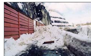
雪崩による交通障害発生
