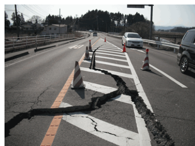
国道349号角田市江尻付近被災状況
