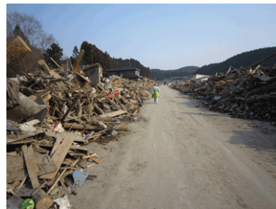
国道398号南三陸町志津川 小森付近被災状況
