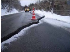
路線名：国道459号 箇所名：猪苗代町字長坂地内
