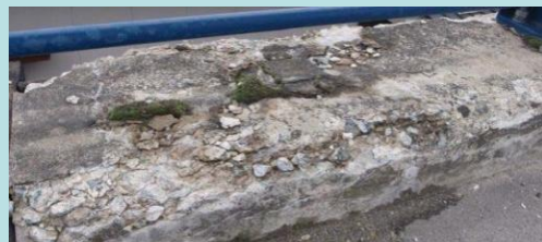
寒さによる損傷(凍害)
