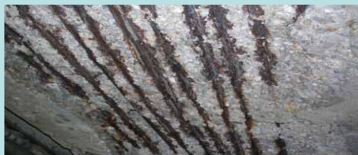
塩による損傷(塩害)
