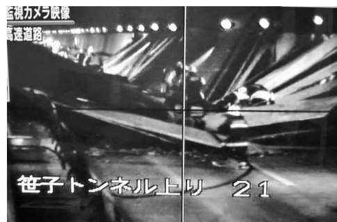
写真 1 笹子トンネル事故(H24.12.2)
