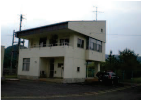
▲ダム管理所外観
