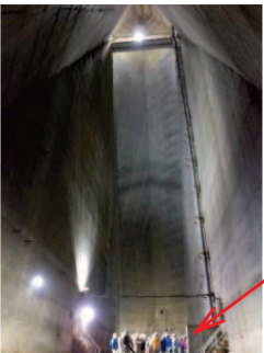
▲中空重力式ダムの内部
