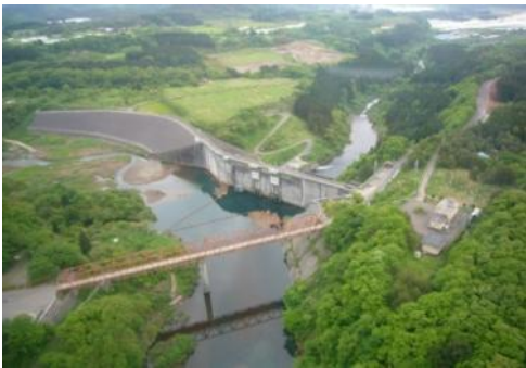
▲重力式コンクリートとロックフィルの複合構造
