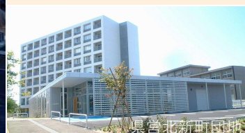
県営北新町団地
