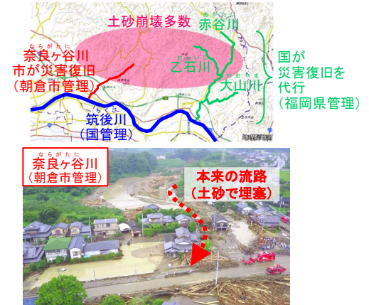
国が準用河川の災害復旧を代行することが想定される例 （平成29年九州北部豪雨（福岡県・筑後川水系））
