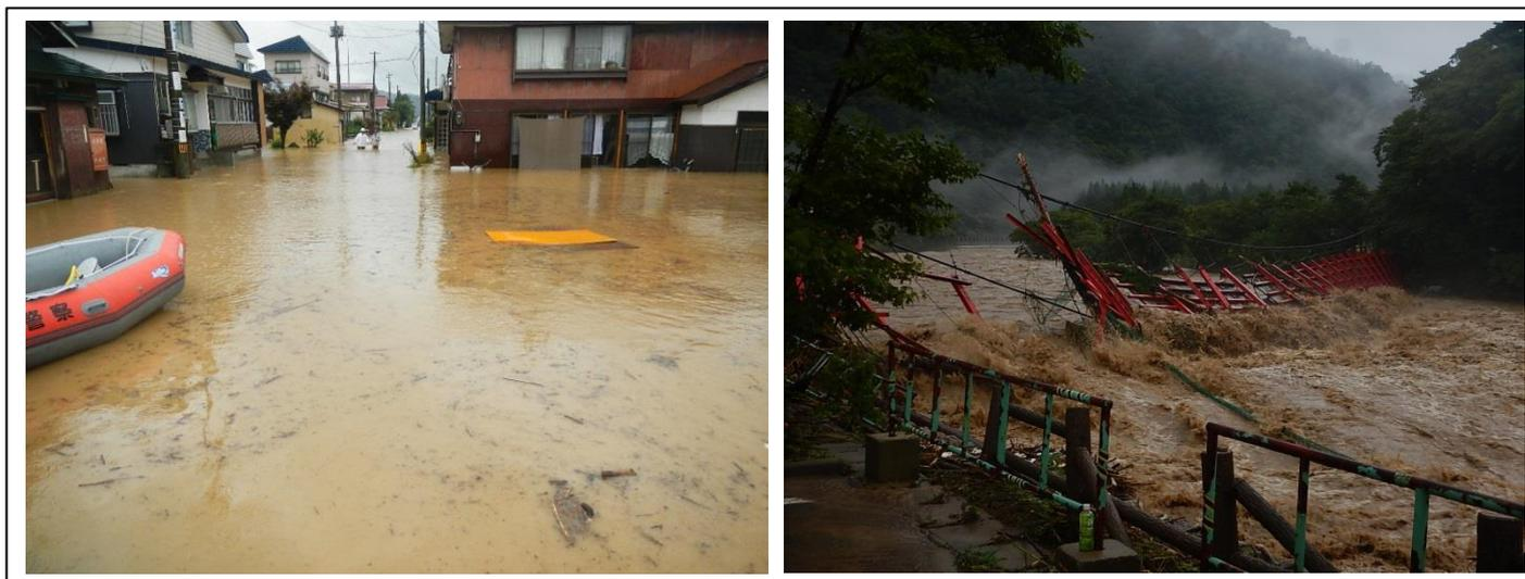
写真 2.3-2 8 月 31 日 戸沢村蔵岡地区の浸水状況(左)と最上小国川のつり橋崩壊状況(右)
