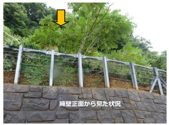
写真 3.1-6 擁壁による斜面崩落土砂の捕捉状況（鮭川村下牛潜地区：平成 30 年 8 月 31 日 ）
