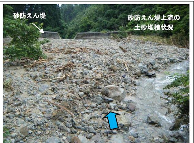
写真 3.1-5 砂防えん堤の土石流捕捉状況（白鷹町高玉地区：平成 25 年 7 月 18 日 ）
