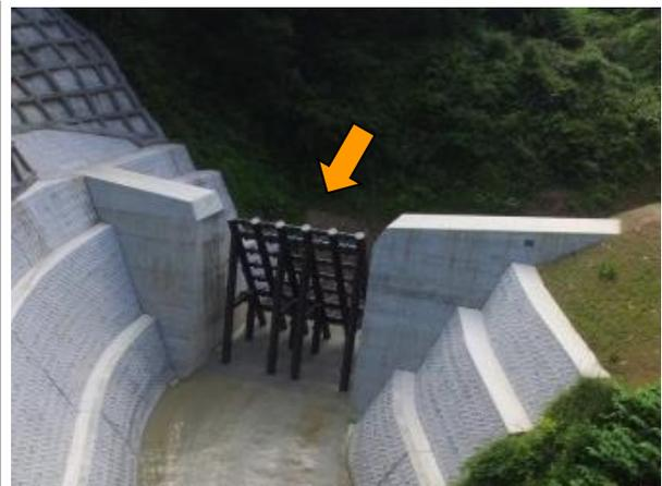
写真 2.6-2 透過型構造を有する砂防えん堤の事例
