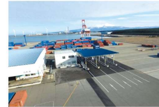
管理上屋(管理棟、トラックゲート)
