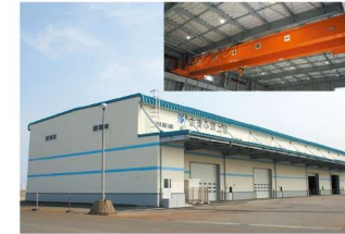
古湊ふ頭上屋(天井クレーン設置、吊上能力:20t*)
