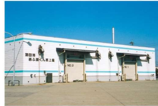
西ふ頭くん蒸施設
