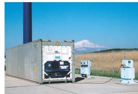
冷凍(リーファー)コンテナとリーファーコンセント 電源設備使用料 31円/kwh
