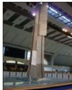
左：落下した天井の換気用ルーバー （静岡県立水泳場） 右：崩落した駿府城址の石垣
