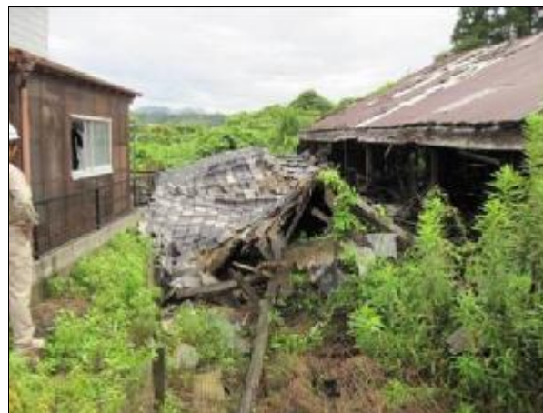
写真6 全壊した瓦工場
