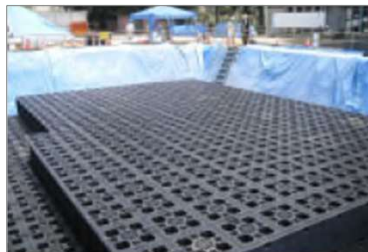
▲雨水貯留施設
