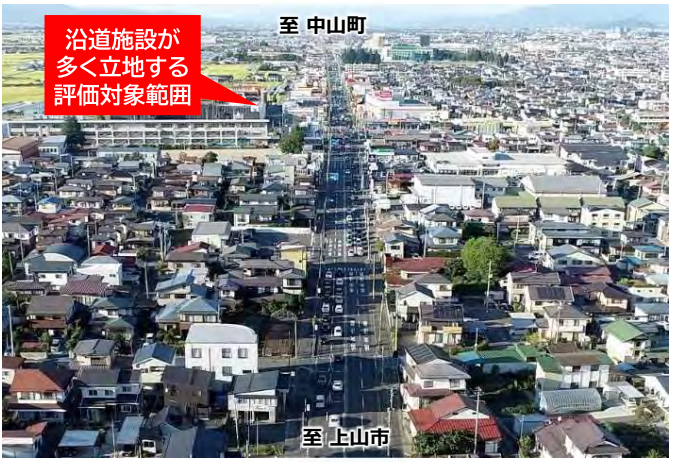
【写真1】(主)山形上山線の状況
