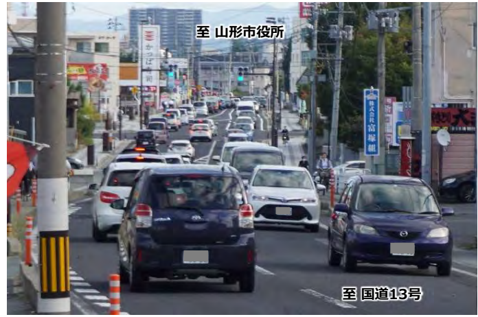
【写真2】国道112号の状況
