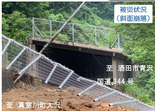
大雨で斜面の土が道路まで崩れ擁壁が壊れました
