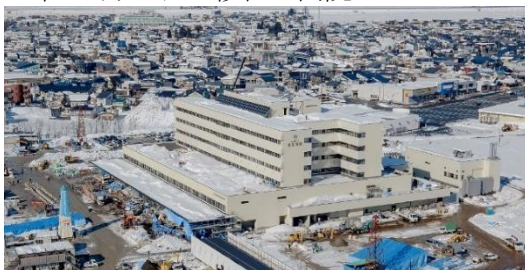
新病院建設状況 (R5.1.19 撮影)
