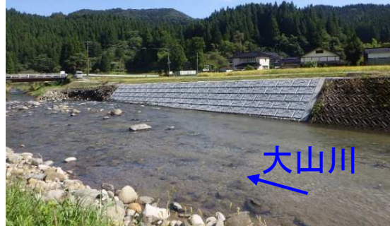
護岸を復旧しました
