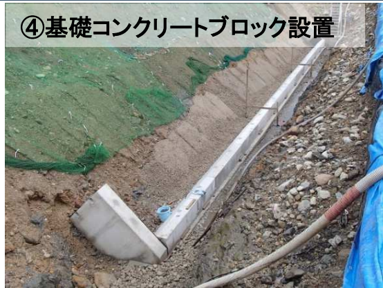
護岸の足元部分を設置します
