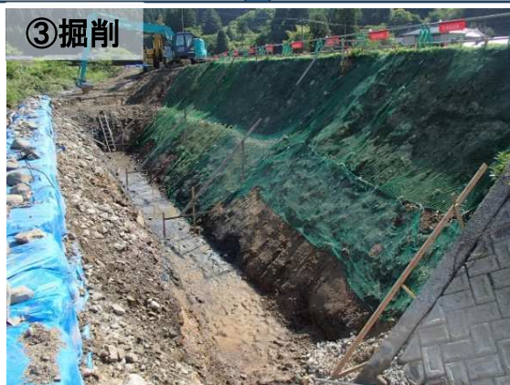
復旧する護岸の足元まで掘ります
