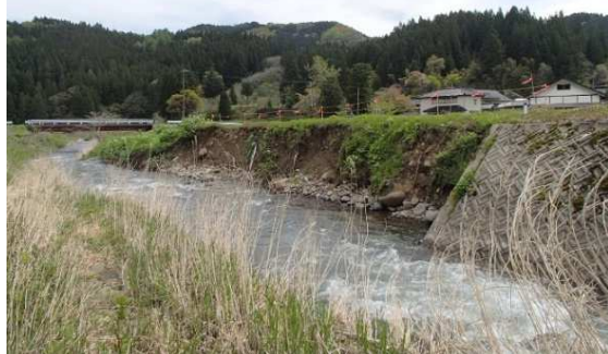
壊れた護岸を復旧します
