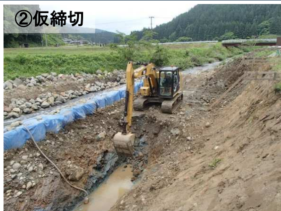
作業時に川の水が入らないように囲います
