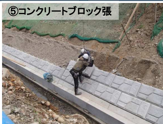
護岸のブロックを張ります
