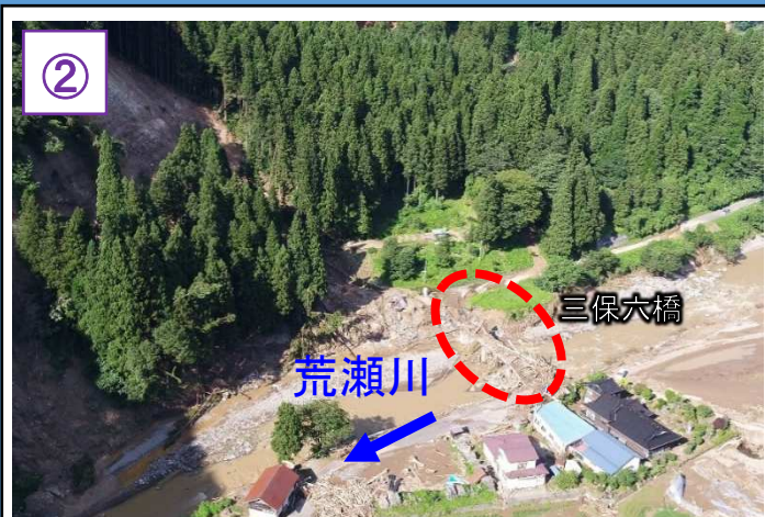
さぶろく ▲ 荒瀬川_三保六橋の落橋状況
