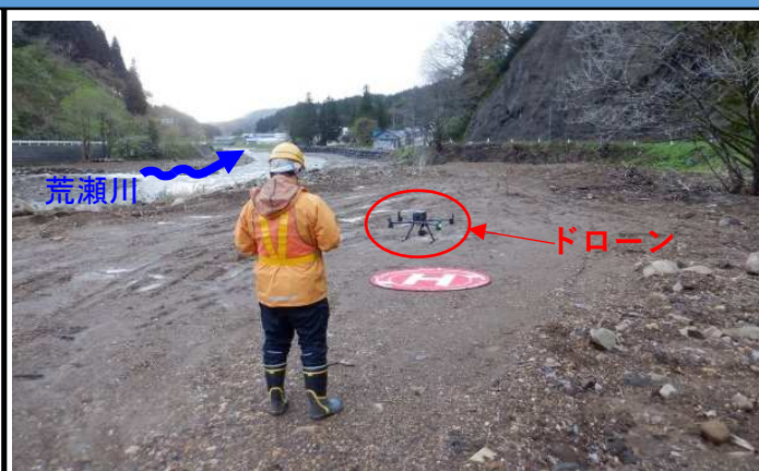
▲ 荒瀬川_ドローン測量作業の状況 短時間かつ広範囲な測量を実施
