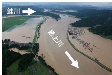
【国】最上川44.3k付近(出水の状況)
