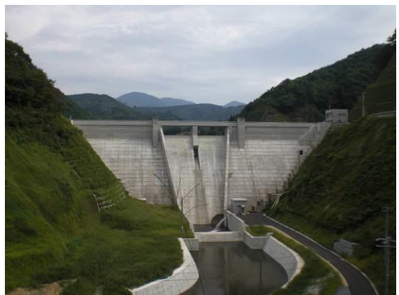
◆留山川ダム全景【H23年.6月末完成】
