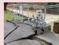
水道の復旧 (被災した浄水場)
