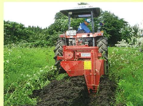
機材導入（溝掘機）
