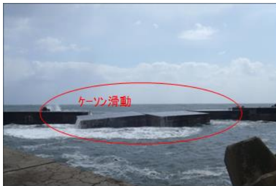
平成 24 年 4 月低気圧による被害状況（飛島漁港）
