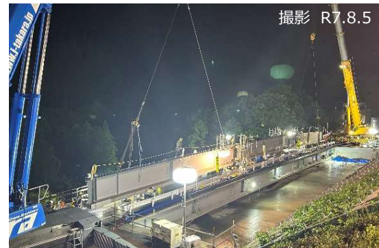
夜間全面通行止めによる桁架設状況
