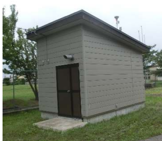
測定局舎（鶴岡錦町局）
