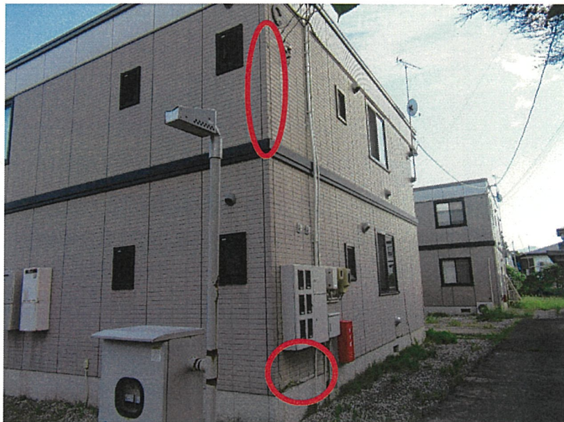
米沢第9号職員アパート C棟凍害補修箇所図（7か所）
