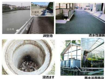
雨水貯留浸透施設の例
