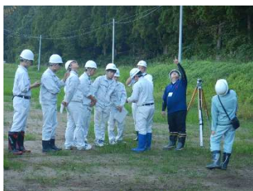
UAV 操作による現場調査
