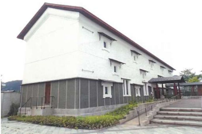
外観（南・東面）
