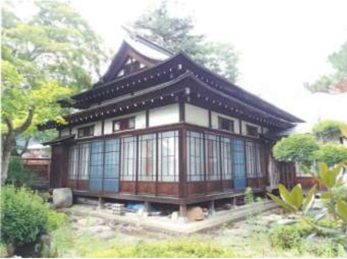
外観（南・東面）
