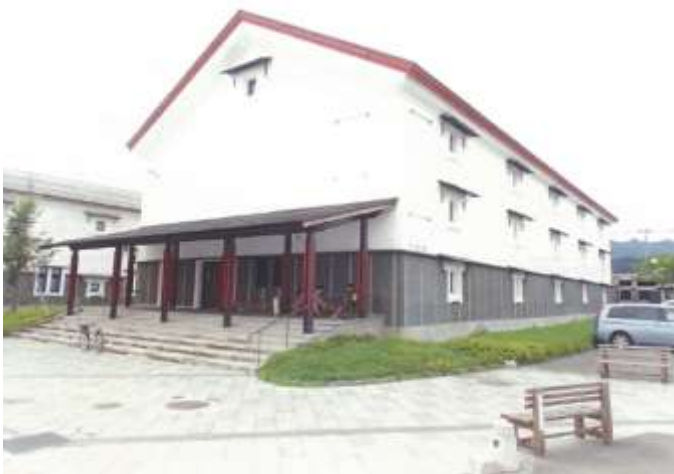
外観（南・東面）
