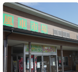
⑥ 道の駅しょうない 風車市場
