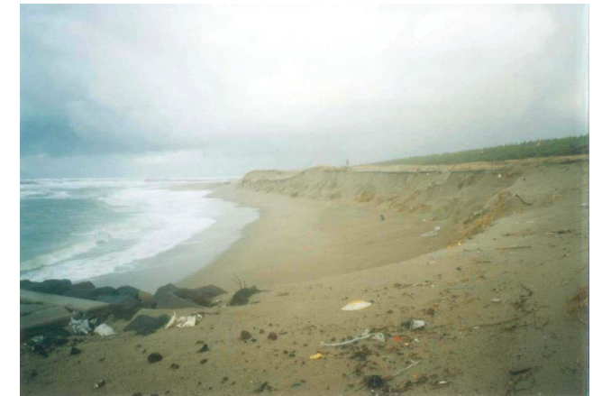
比子地区（侵食による浜崖 2) の状況）
