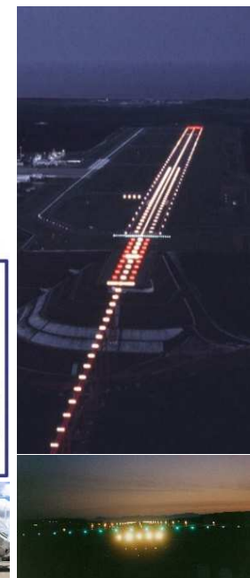
写真: 空港施設 (照明・灯火のLED)
