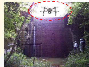
<UAVによる砂防施設点検> 危険箇所での作業が不要となり、 迅速で効率的な点検が可能に
