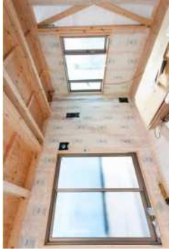
■寒さ対策・断熱化（断熱材設置）
