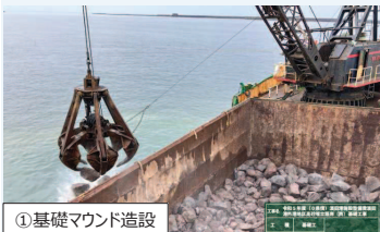
①基礎マウンド造設
