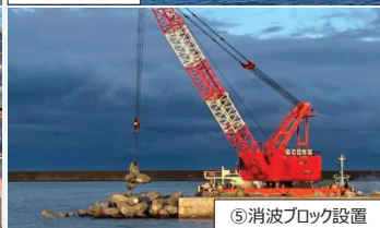
⑤消波ブロック設置
