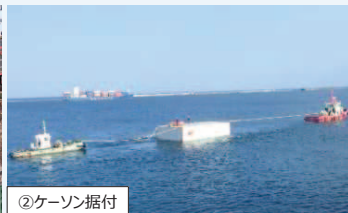
②ケーソン据付
