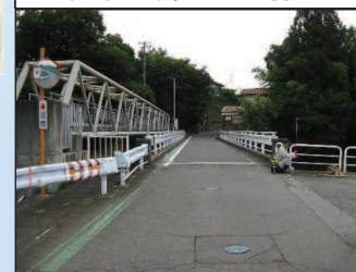
川口橋（左岸より右岸を望む）
