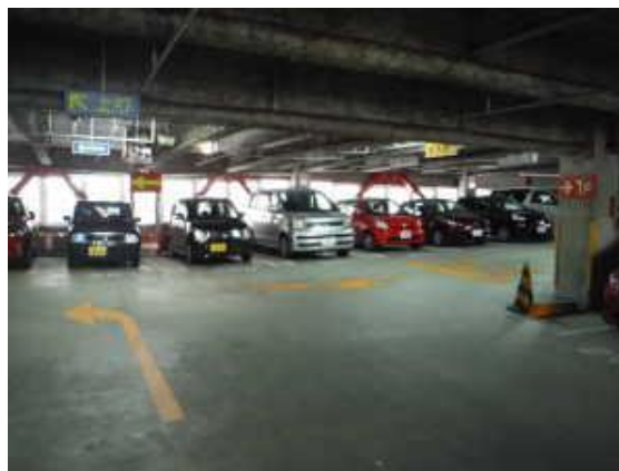
県営駐車場内部
