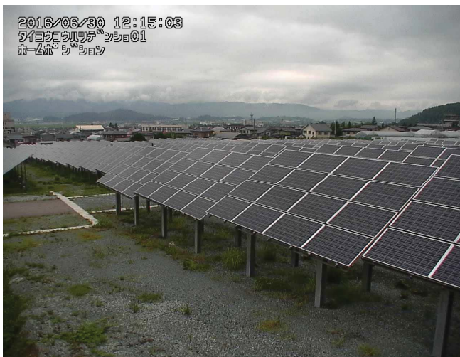
平成28年6月30日 12:15 太陽光発電所の状況
