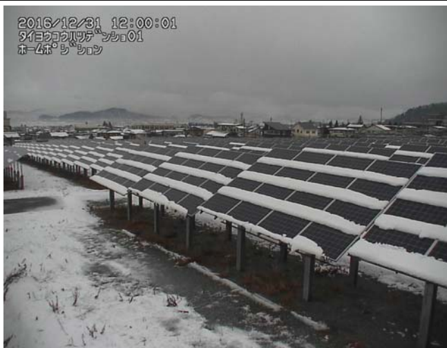
平成28年12月31日 12:00 太陽光発電所の状況
