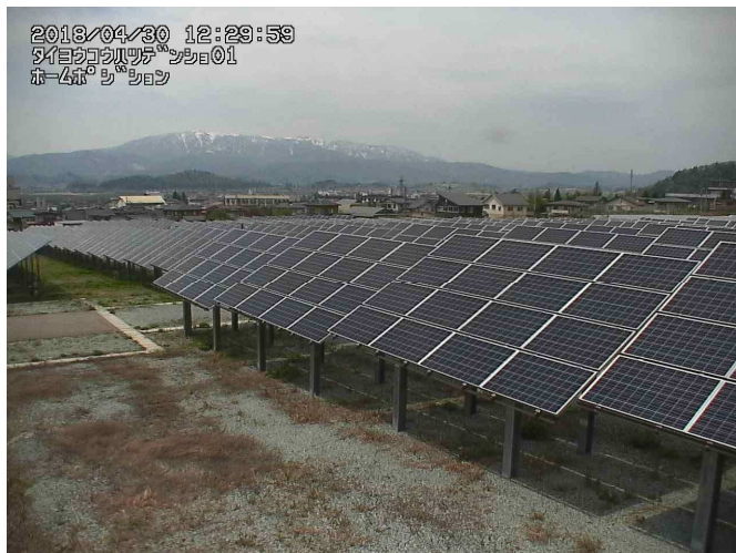
平成30年4月30日 12:30 太陽光発電所の状況
