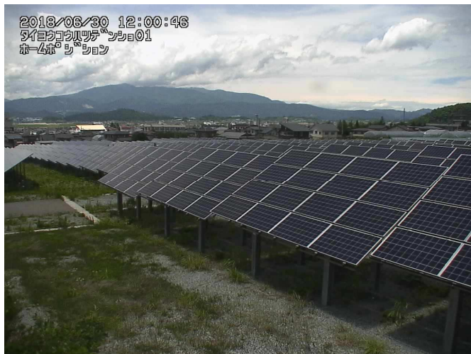
平成30年6月30日 12:00 太陽光発電所の状況
